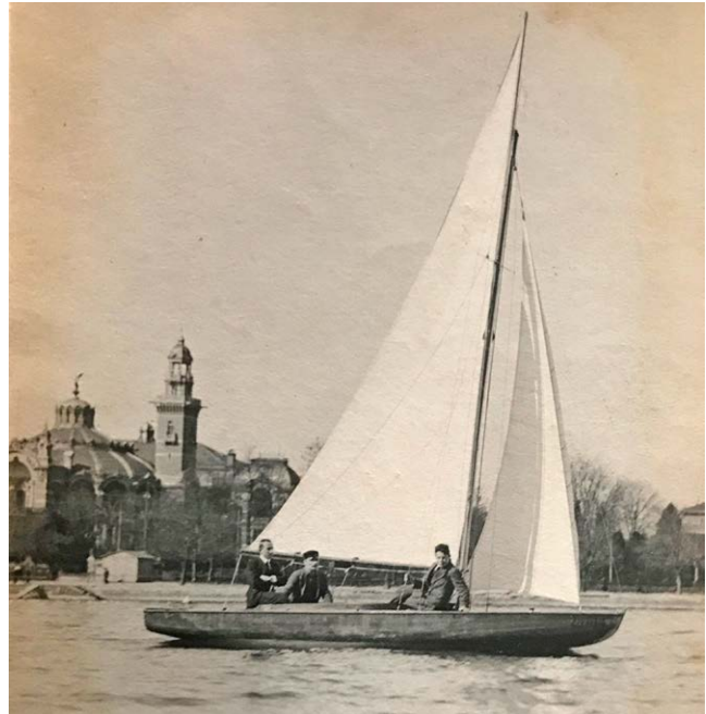
Undine (Eigner A. Schmid) vor dem Bau der ursprünglichen (neuen) Tonhalle-Anlage am Alpenquai. Der seeseitige Teil dieser im türkischen Stil erbauten Anlage wurde 1939 abgerissen und durch das heutige Kongresshaus (Architekten Häfeli Moser Steiger) ersetzt.
