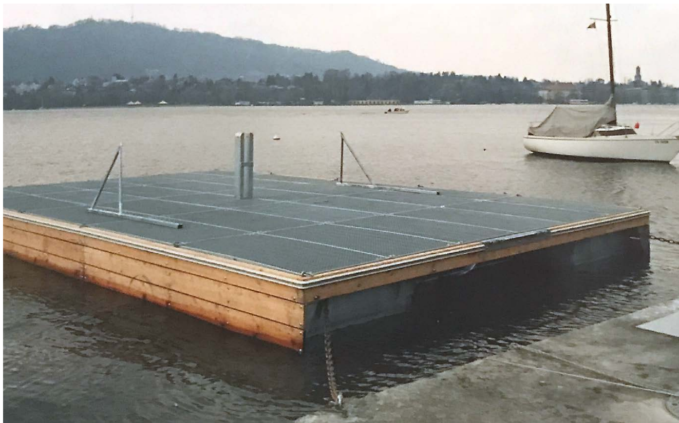
Einbau neues Anlegefloss.
